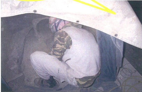
テント内での作業による防音対策
